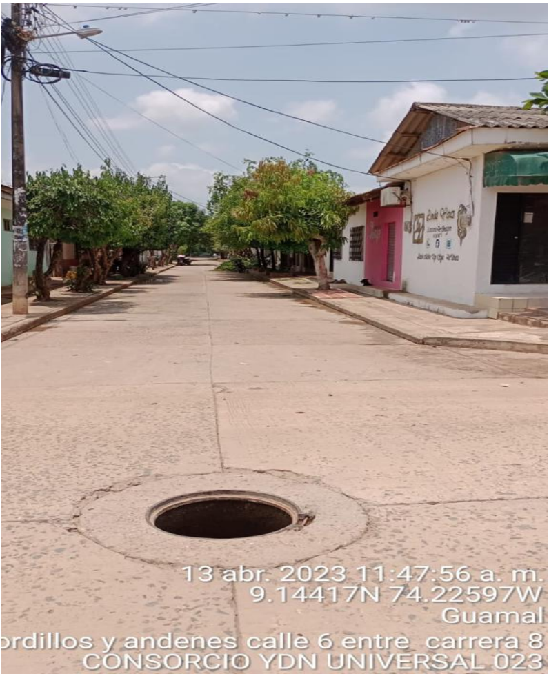
13 abr. 2023 11:48:23 a. m. 9.14421N 74.22600W Guamal ordillos y andenes calle 6 entre carrera 8 CONSORCIO YDN UNIVERSAL 023
